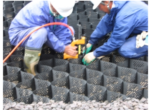
施工写真 上左：端部位置出し 上右：端部固定 下右：セル接続（エアーステープル）
