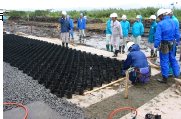
施工写真 上左：端部位置出し 上右：端部固定 下右：セル接続（エアーステープル）
