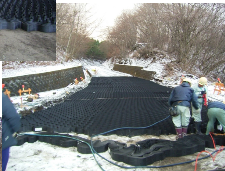
・ハイパーセル施工状況②
