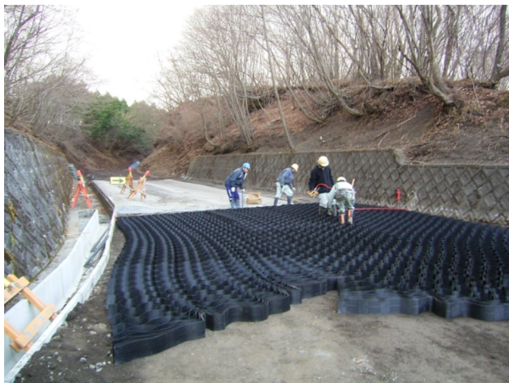
・ハイパーセル施工状況①
