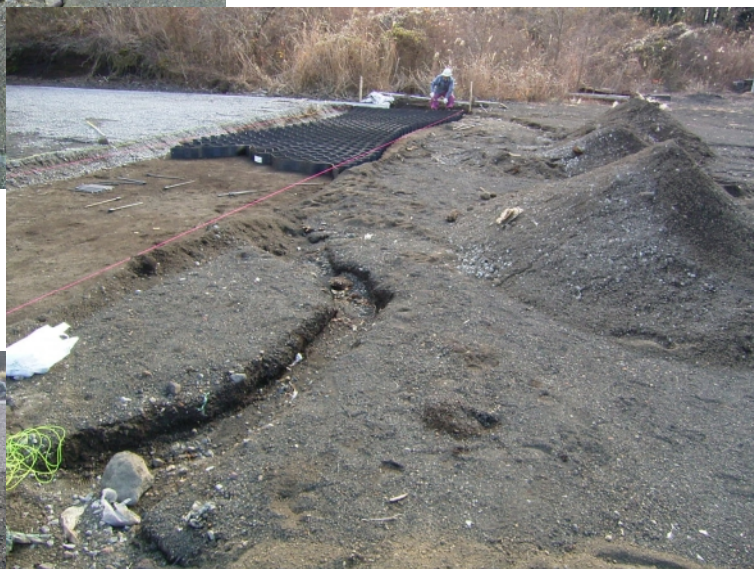
・施工状況とスコリアの浸食状況
