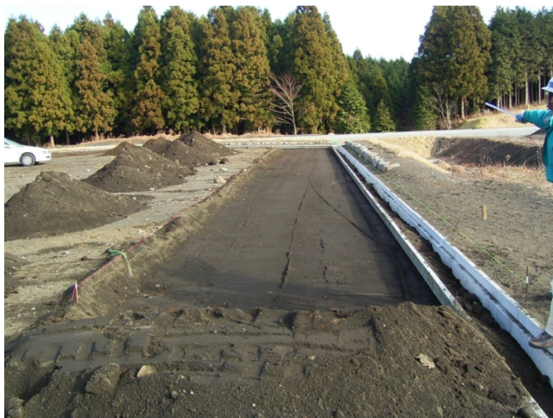
・ハイパーセル敷設前の状況
