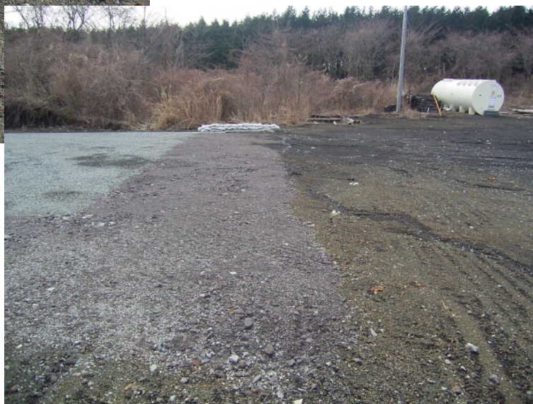
・施工完了後3ヶ月の状況②
