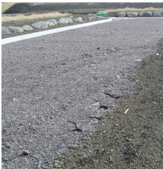
・施工完了後3ヶ月の状況①
