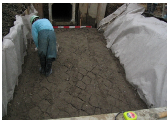
上マットレス転圧工
