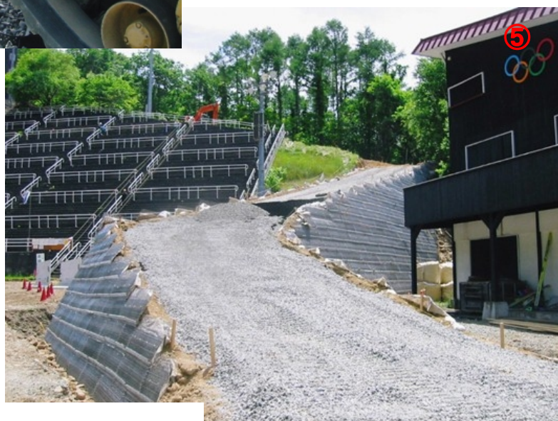
写真⑥:施工後の写真。 施工前は走行が困難 であつた重機も容易 に走行できるよう になった
