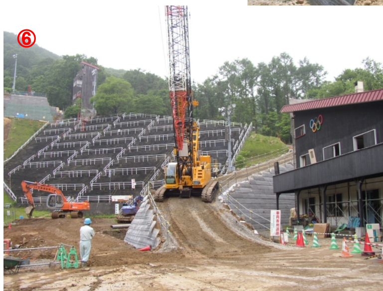
写真⑥:施工後の写真。 施工前は走行が困難 であつた重機も容易 に走行できるよう になった
