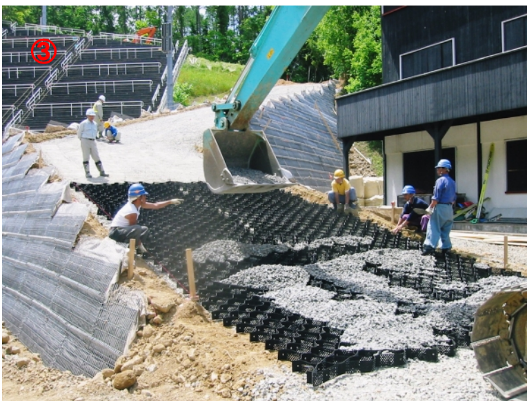
写真③:充填材(碎石) 充填状況
