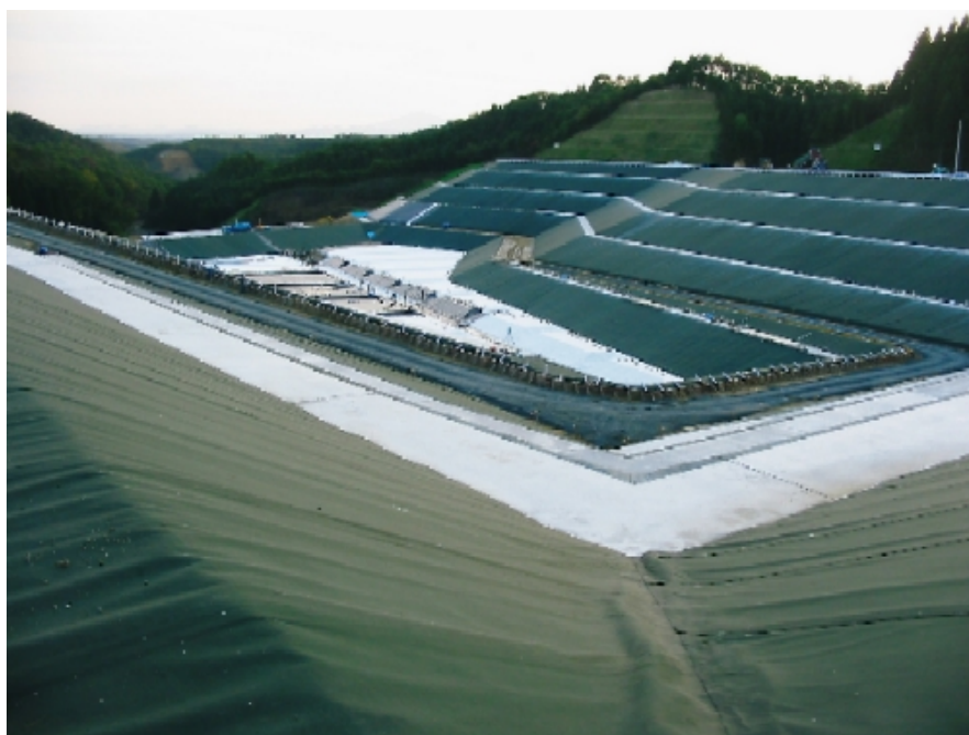
上層路盤施工写真
