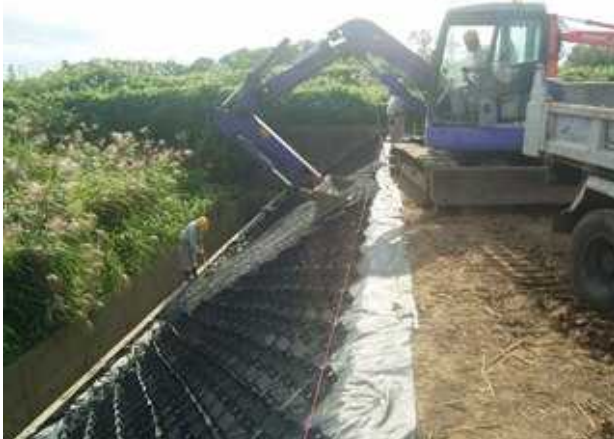
単粒度碎石充填・転圧工
