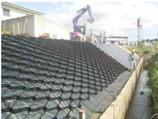
単粒度碎石充填・転圧工
