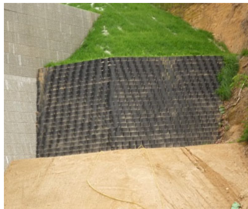
堰堤下流部保護擁壁
